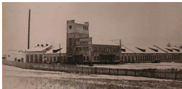
Строительство Угличского часового завода. 1930-е гг.
